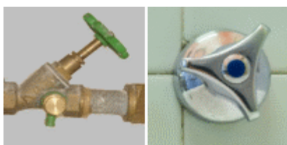
Wohnungsabspernung Kann auch ein verchromtes Unterputzventil sein
